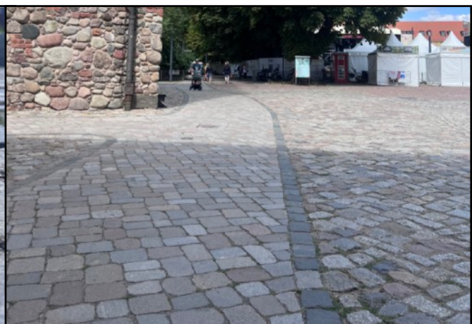
Abb. 06: reibungsarmes Pflaster im Denkmalschutzbereich (Unterschied: geschnittenes - rollbares - und geschlagenes Pflaster)
