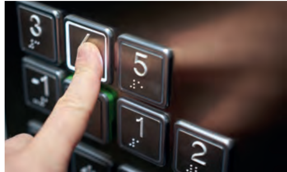
Aufzugtastatur mit Profilschrift und Braille, Leuchtkennzeichnung der Taste
