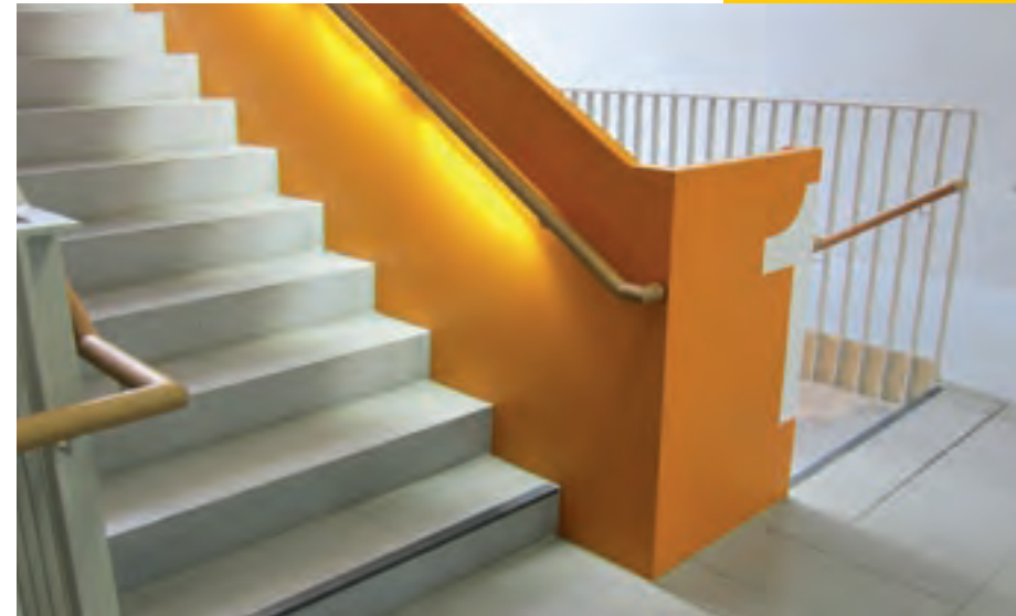
Kontrastreiche Gestaltung eines Treppenhauses, Gymnasium Trudering, München
