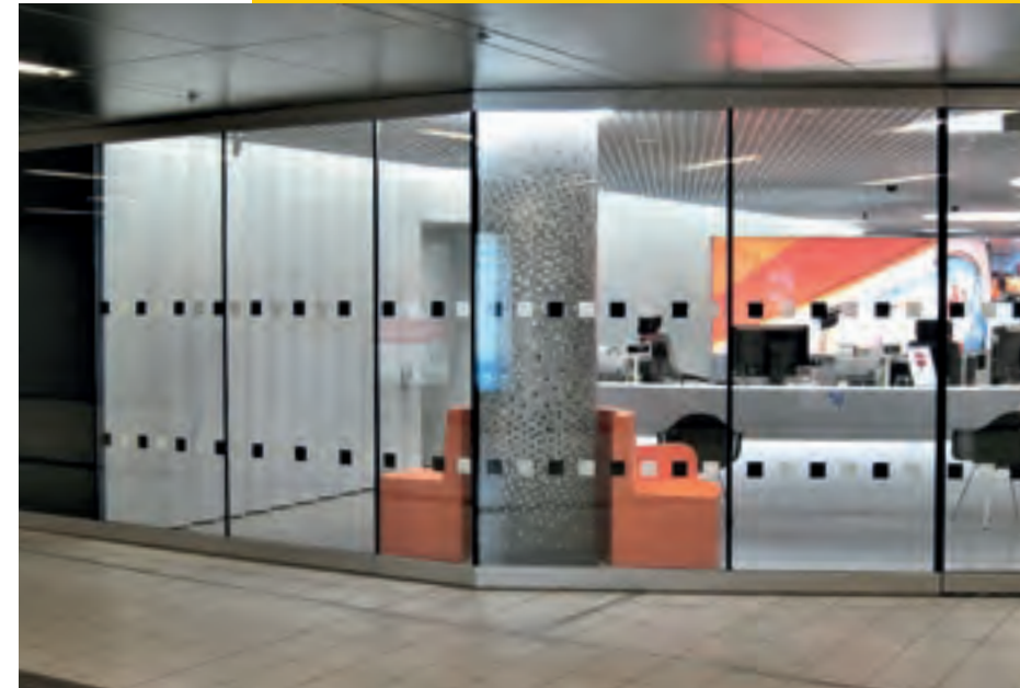
Sicherheitsmarkierungen an Glaswänden, Marienplatz Sperrengeschoß, München
