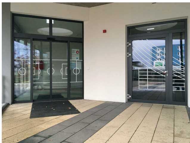
Fußballfeld (große Glasschiebetür links) und die Tartanbahn für die Nebeneingangstür
